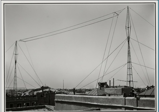
La prodigiosa antena de la estación “R 5”, del señor Elena, tal como estaba antes de producirse el forzoso desmantelamiento.
