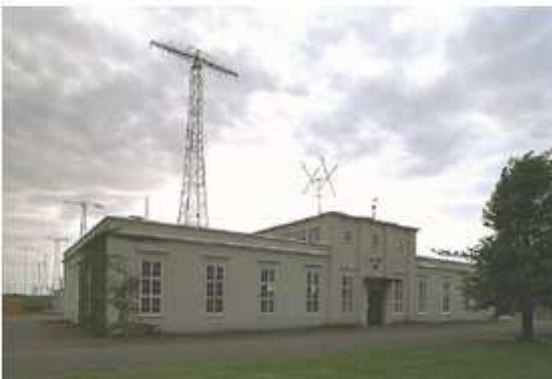
Edificio principal de Grimeton Radio, al fondo la hilera de torres.
