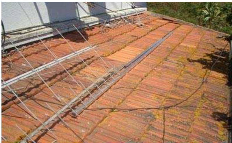
Ilustração 17 – Tubo alumínio secção quadrada para o bum dos dipolos de 40 e 80 mts.
