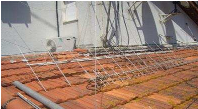
Ilustração 20 – Antenas de VHF e UHF cruzadas polarização axial direita para Satélite
