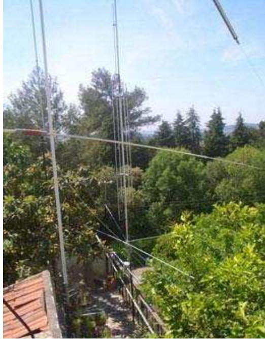
Ilustração 19 - Antenas: Titan Eagle HF , antena VHF vertical colinear 7x1/2 ondas, antena 5/8 para 10 mts. e uma 2 BDQ 40 e 80 mts.
