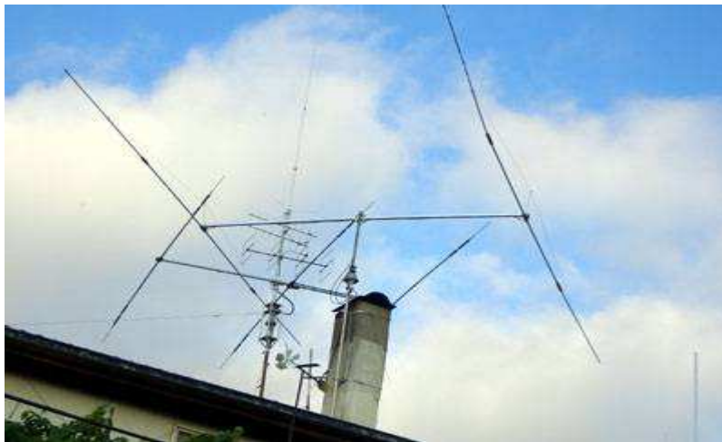
Antena dos 40 e 80 metros no mesmo Boom, dipolos suportados com fio de nylon de 2m/m
